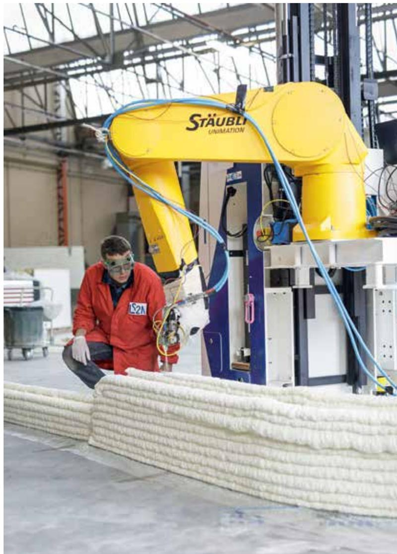
Le robot de Batiprint 3D construit le gros œuvre d'une maison de 95 m<sup>2</sup>.
